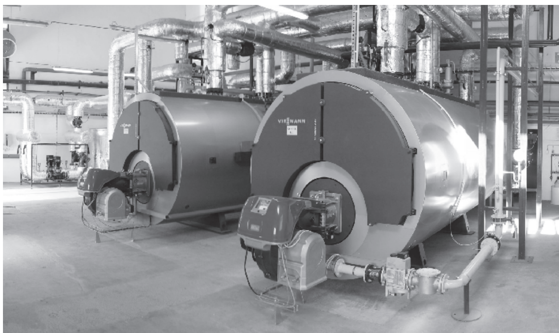
Náročná rekonstrukce kotelny a celého tepelného hospodářství Demanding reconstruction of the boiler house and of the entire heating system
